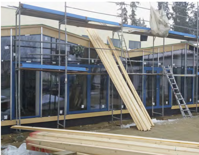
Momentaufnahme des Bauzustands der Mittagsbetreuung (11.12.2020)
